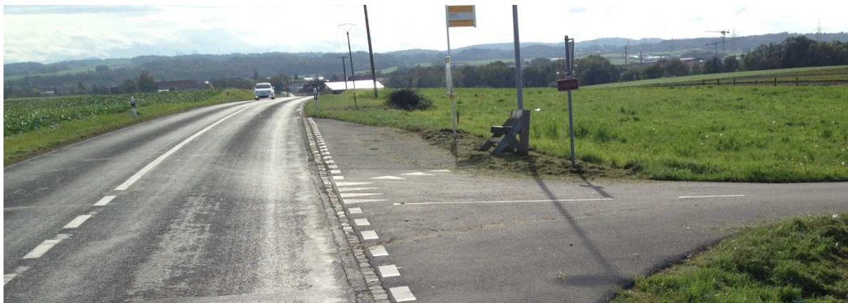
Figure 4 : Arrêt de bus existant non conforme à la LHand
